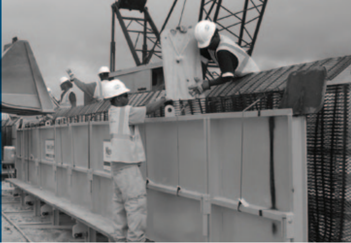
Separadores de plywood mantienen separadas las dos capas principales de geomalla para abrir bien el colchón al llenarlo.
