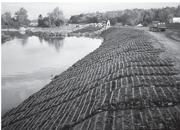
IMAGEN 6: Instalación terminada para protección de ribera.
