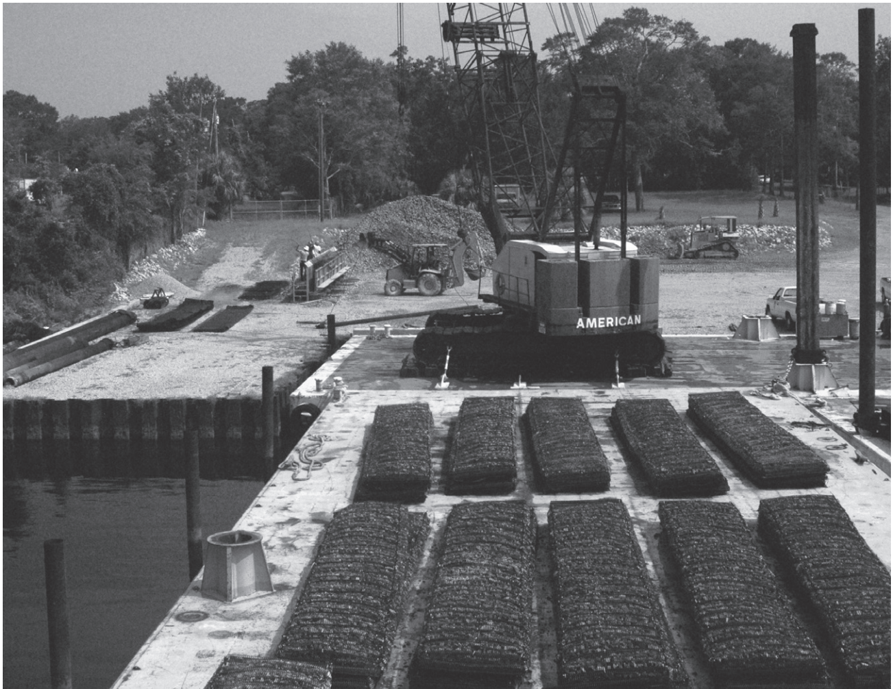
Unidades apiladas en grupos en espera de colocarse sobre una tubería en Bay County, Florida.
