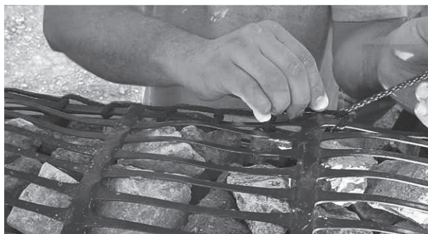
IMAGEN 1: Los nudos deben hacerse de forma que no se deslicen ni se aprietan.
