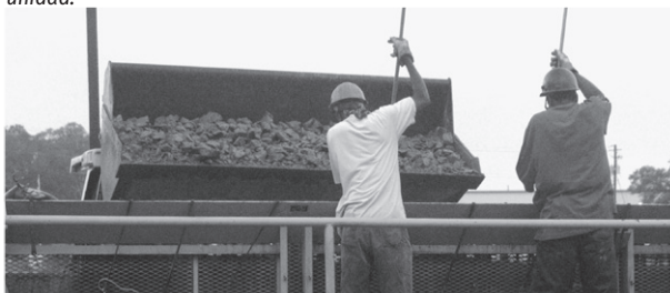
El apisonado compacta la piedra para que no se desplace al izar o colocar el colchón.
