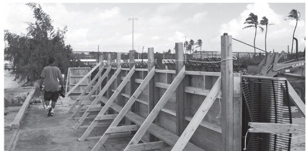
IMAGEN 3: Este filling frame de madera se construyó para un proyecto de colchones marinos en Kauai, Hawái.
