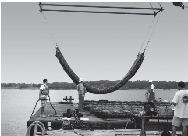
IMAGEN 5: Un Triton® Marine Mattress se baja sobre una tubería submarina para protegerla.
