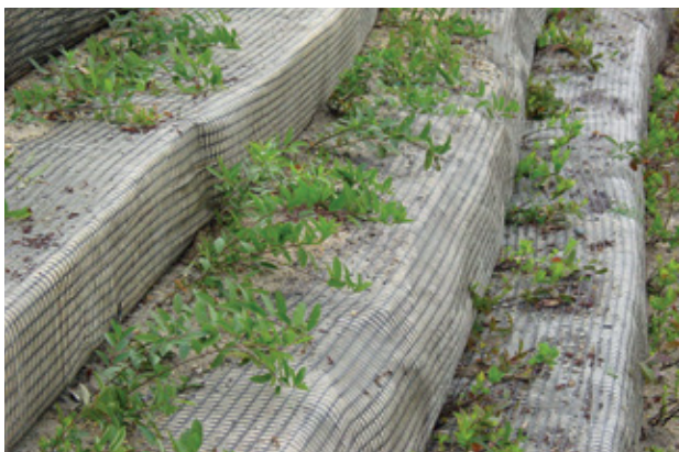
Tensar® VRSS promueve la propagación de sistemas de raíces vegetativas nativas para fortalecer las estructuras de refuerzo a través del tiempo.
