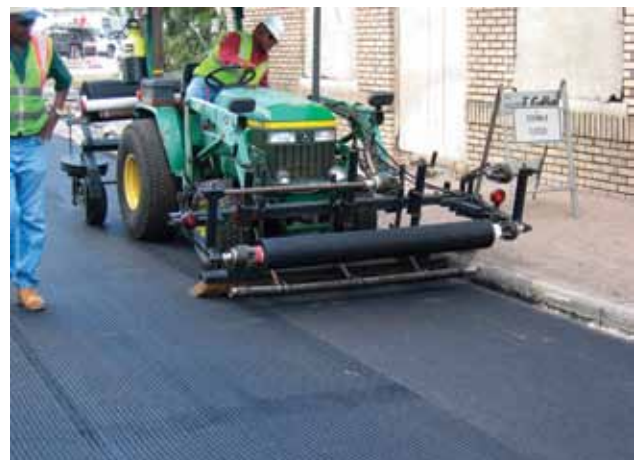
Una instalación de ancho completo con GlasGrid usando un dispositivo de instalación de alta velocidad de 1.5 m (5 pies) de ancho.
