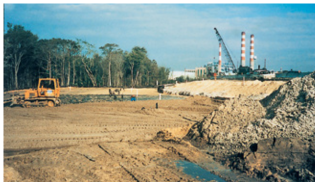
Rampas de acceso a puente – Carretera estatal 15/US 17, Florida
