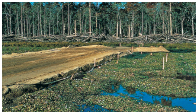
Dique de Westminster – Jefferson Parish, Luisiana
