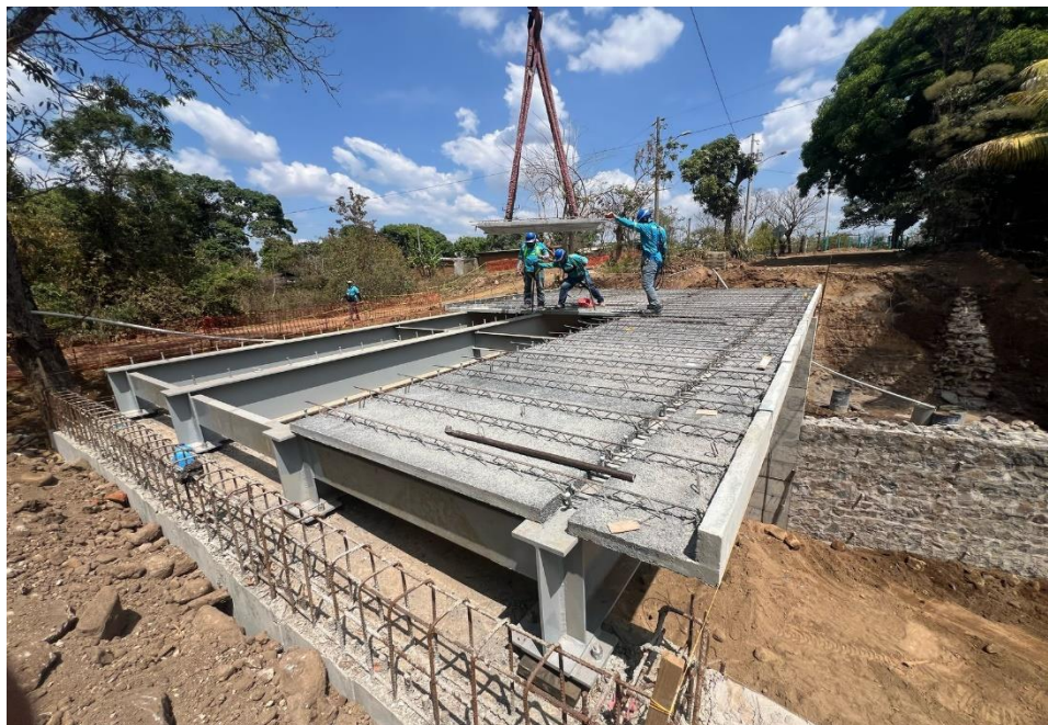
3 Puentes para DOM, Ahuachapán, Calle hacienda La Labor (2025)
