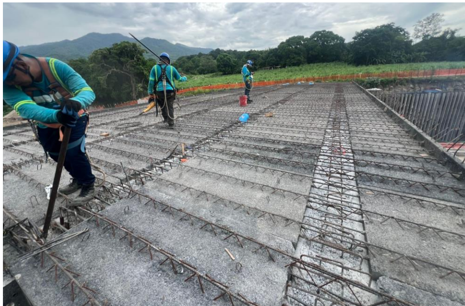
Puente para Constructora El Salvador municipio de Guazapa (2025)
