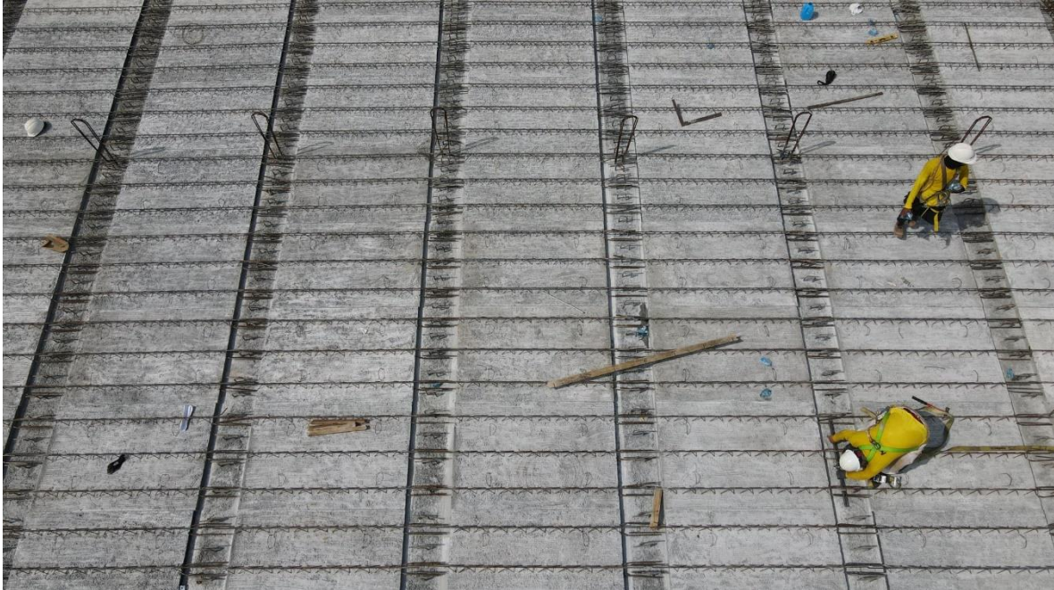
2 puentes Viaducto carretera Comalapa (2021)
